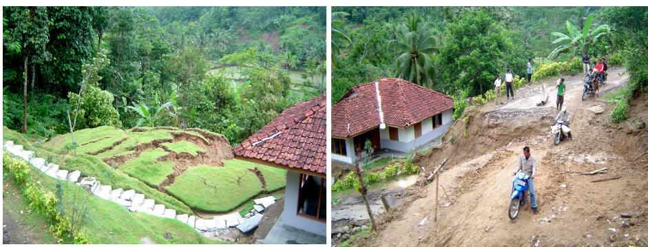
Gambar 7. Gejala nendatan di Desa Kutawaringin, Kec. Selajambe, Kuningan, memperlihatkan pola rekahan dan retakan yang khas (kiri), dan gejala tanah longsor yang memutuskan badan jalan pada jalur antara Selajambe – Subang, Jawa Barat (kanan).
