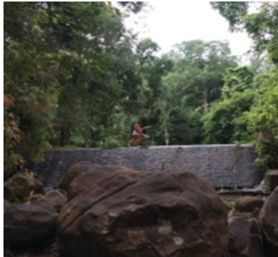
Gambar 3. Bendungan di stasiun III.
